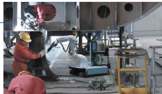
溶接作業現場イメージ
